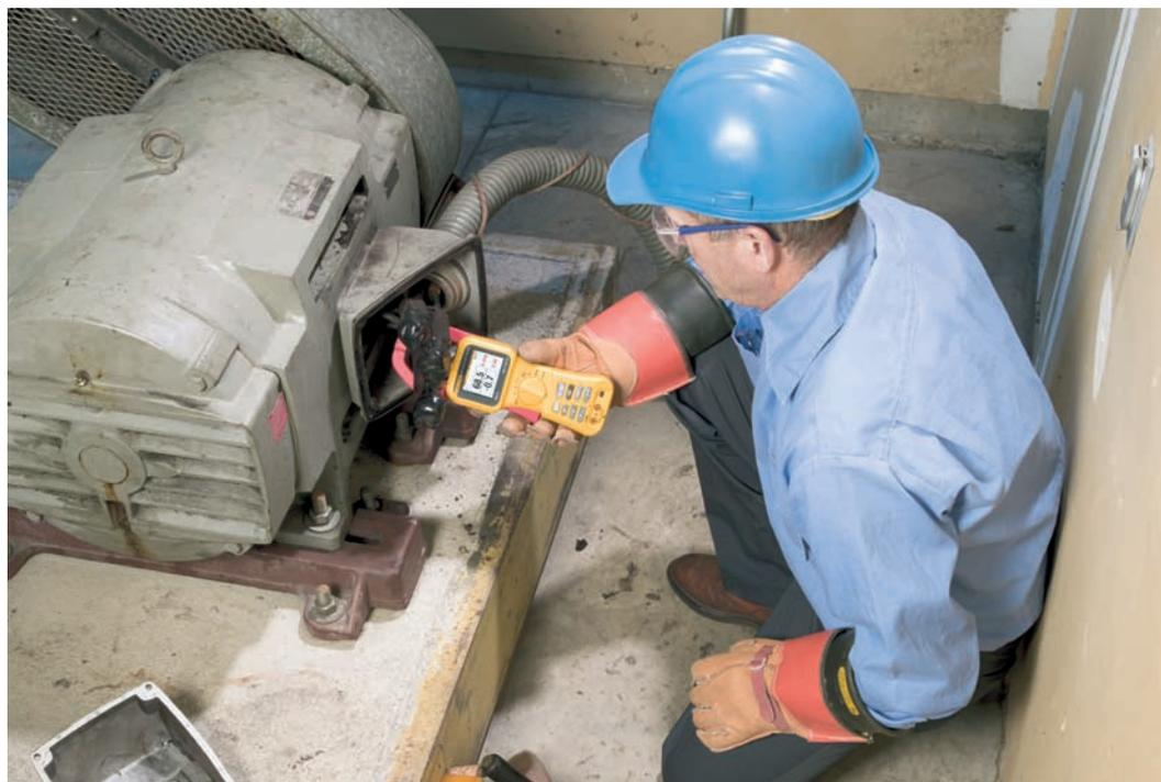
Ponga el mando selector de función del Fluke 345 en la posición Forma de Onda y podrá ver las formas de onda de la tensión y de la corriente. Desde ahí, seleccione cualquiera de las formas de onda y utilice las teclas de flecha para medir la tensión en un punto específico de la onda, así como el tiempo entre los dos puntos de la onda.
