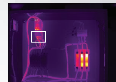
Imagen completa, tomada desde una distancia de 1,5 metros con una cámara infrarroja TiX1000. El área que se muestra en el cuadro blanco está ampliada debajo.
