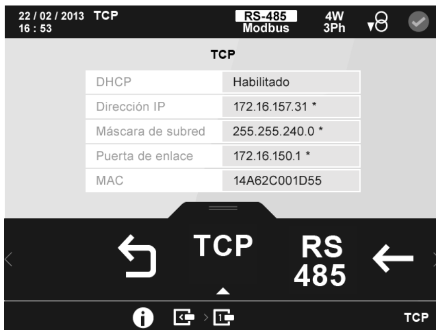
Figura 227: Pantalla de información del módulo Modbus TCP (Bridge) (Comunicación TCP).
