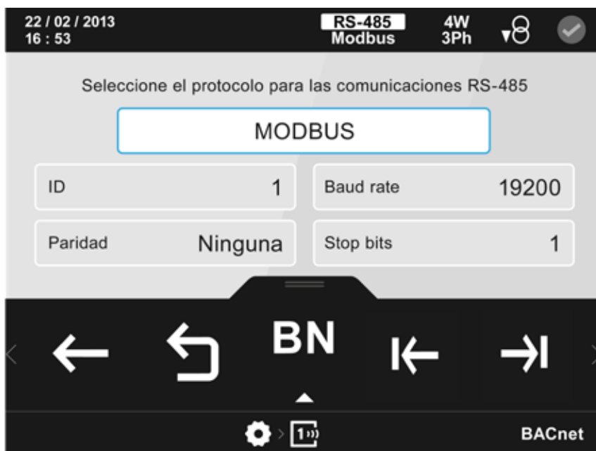
Figura 299: Pantalla de configuración de las comunicaciones integradas ( protocolo Modbus).
