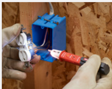
Comprobación de tensión CA en cables
