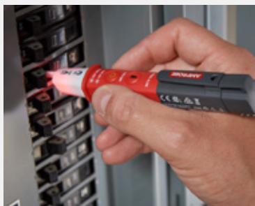
Inspección de interruptores diferenciales
